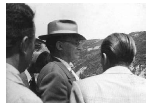
Alcide De Gasperi, all'avvio dei lavori della diga di S. Giuliano (luglio 1950).
