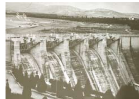
Diga di S. Giuliano.
